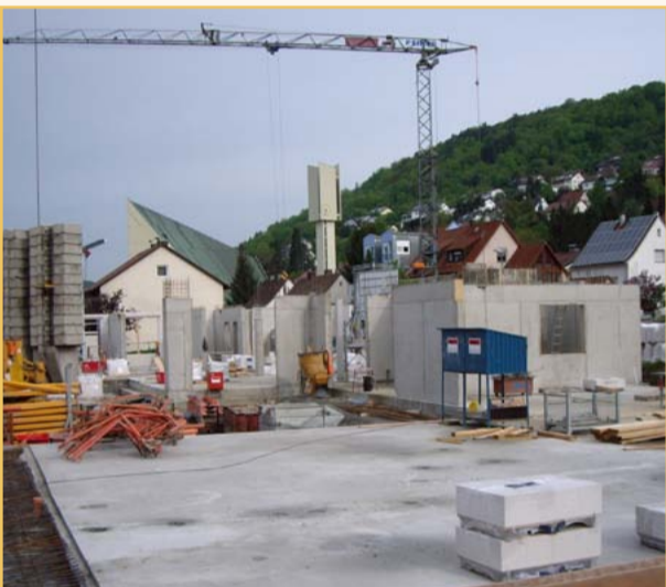
Die Bodenplatte ist fertig (Mai 2013)
