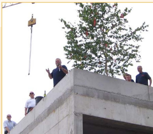
Beim Richtfest (Juli 2013)
