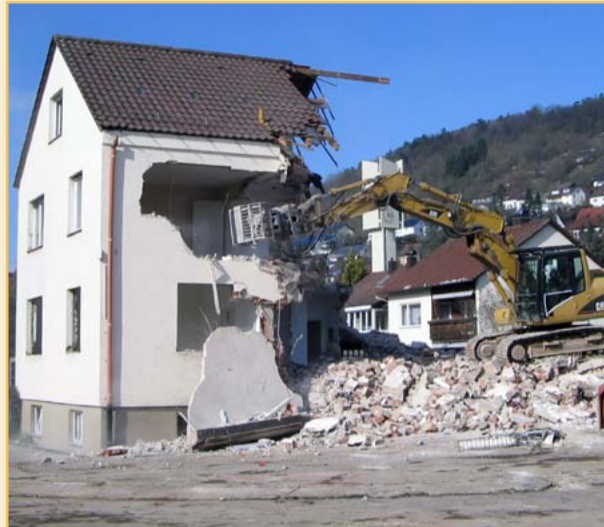
Das Bauhofgebäude wird abgebrochen (Februar 2013)
