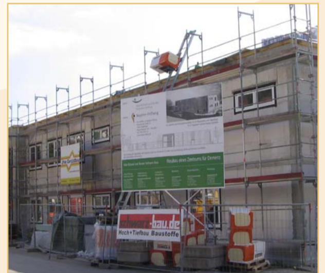
Der Rohbau im Oktober 2013
